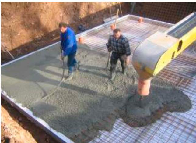
La dalle de radier est coulée et lissée avec un béton prêt à l'emploi.
