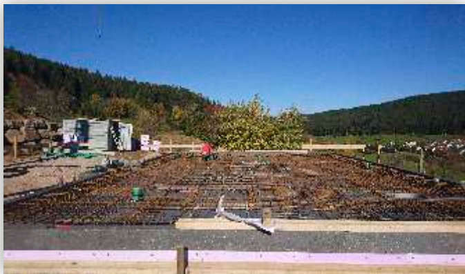
Le radier coffrant isolant est posée en quelques heures - pas de coffrage supplémentaire ni de décoffrage ultérieur
