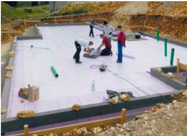
Les tuyaux d'écoulement sont passés au travers du radier.
