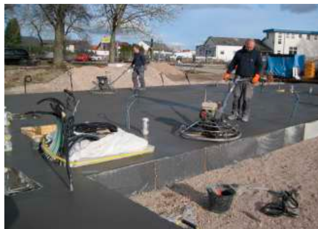
La surface du radier peut être facilement lissée pour une finition impeccable.
