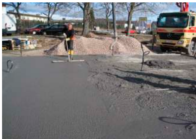
Le radier isolant et les tubes de chauffage sont coulés ensemble avec un béton prêt à l'emploi.
