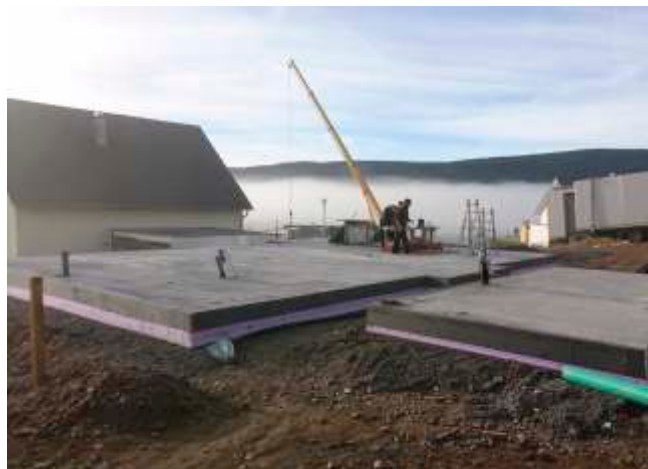
Un radier en béton entièrement isolé thermiquement est la fondation idéale pour une maison passive.
