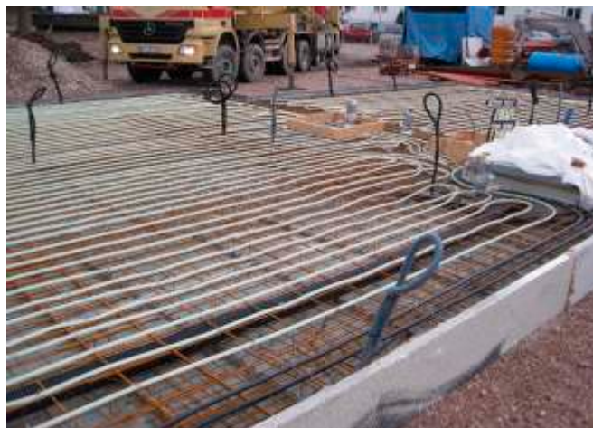
Le réseau de chauffage peut être fixé directement sur le treillis d'armature.
