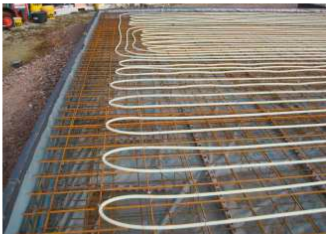
Le radier coffrant isolant MAGU est idéal pour l'activation thermique de la masse et de l'inertie du béton.
