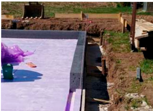
Les panneaux sont posés avec les planelles latérales selon le plan de pose.
